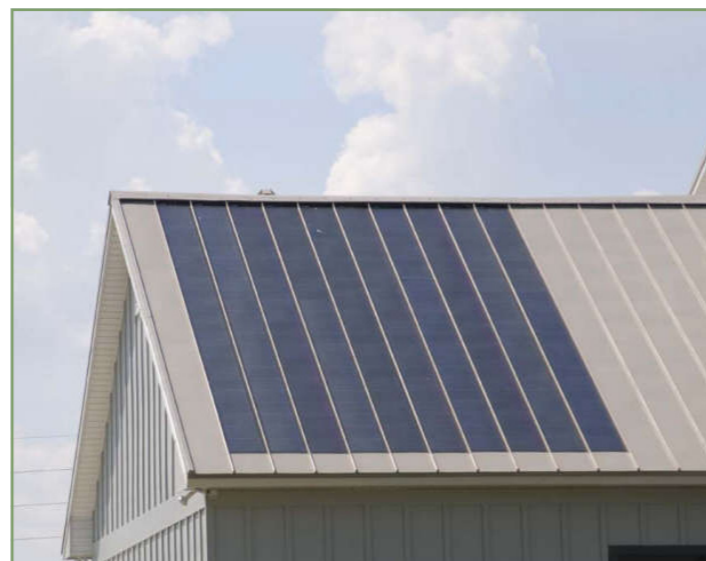
Zonnepanelen op dak
