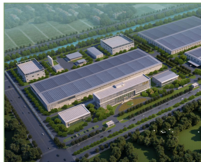
Zonnepanelen op bedrijfsdak
